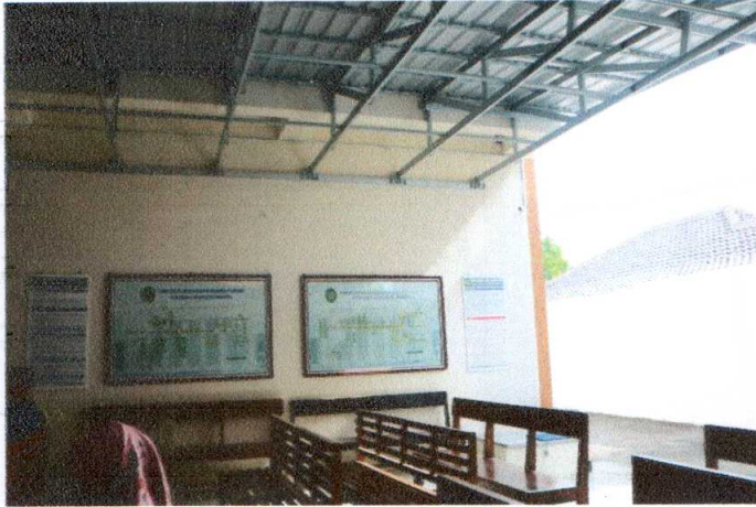
CCTV Luar Gedung Kantor
