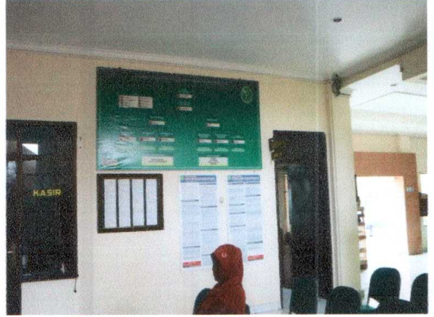
CCTV Dalam Gedung Kantor
