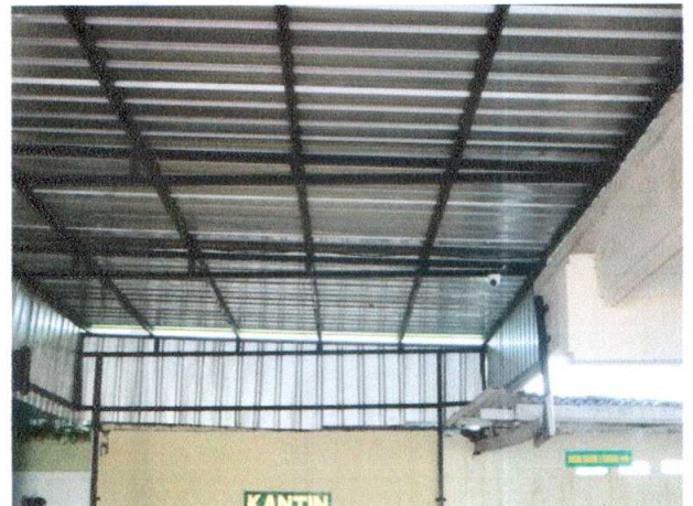
CCTV Luar Gedung Kantor
