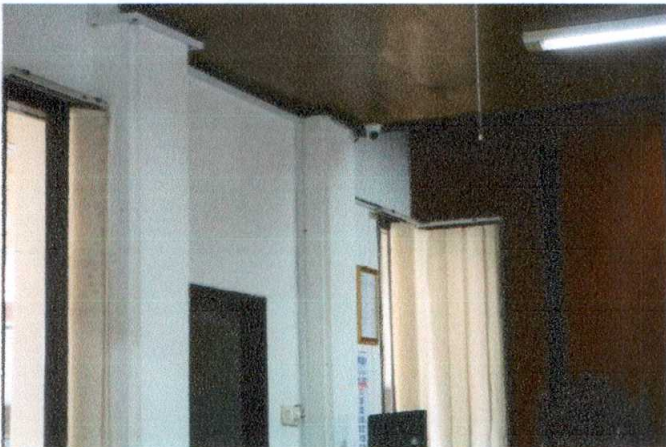
Kamera CCTV R. Sidang
