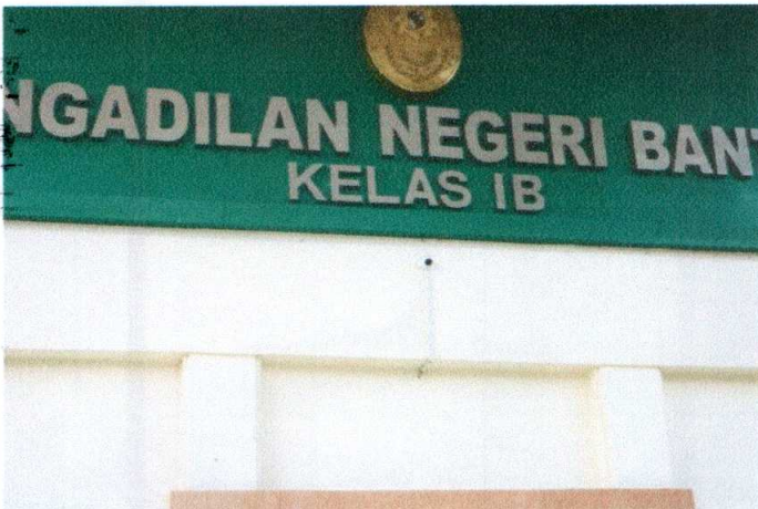
CCTV Luar Gedung Kantor
